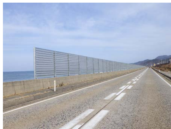
完成した波しぶき防止柵
