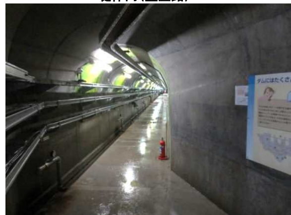
堤体内(監査路)
