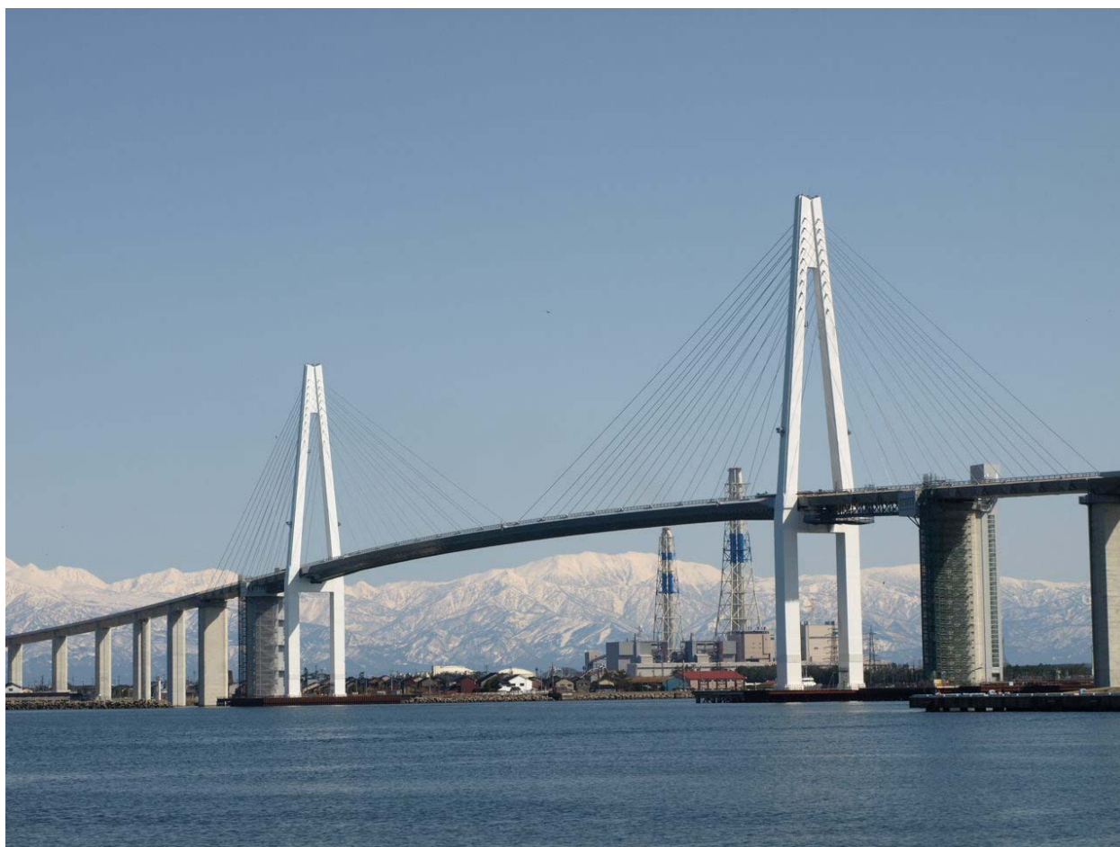
写真：新湊大橋（平成24年4月 海王丸パークより撮影）
