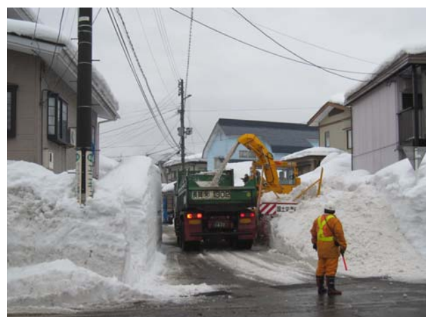
妙高市学校町内で拡幅除雪を行う貸出中のロータリ除雪車
