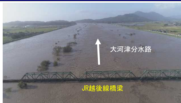
JR越後線橋梁より下流を望む (10/13 15:37撮影)
