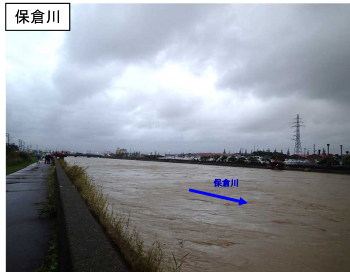
10/13 6:10 保倉川右岸0k5 港町第四排水樋管付近
