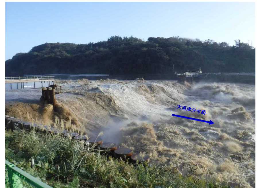
10/13 16:06 大河津分水路右岸8k 第二床固副堰堤付近
