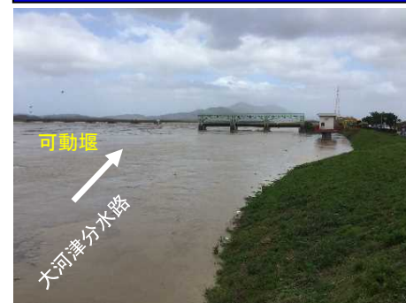
上流より可動堰を望む (10/13 10:03撮影)
