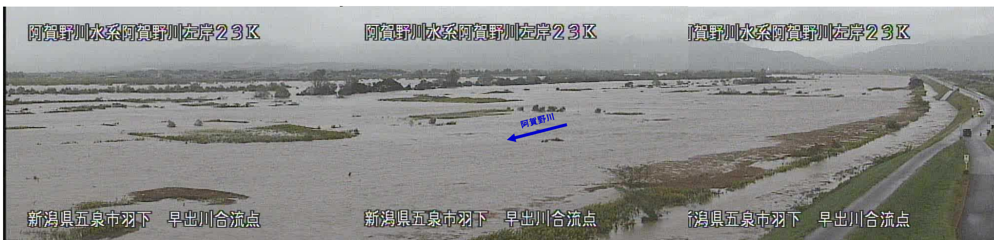
10/13 6:52 阿賀野川左岸23k 新潟市五泉市羽下地先 早出川合流点
