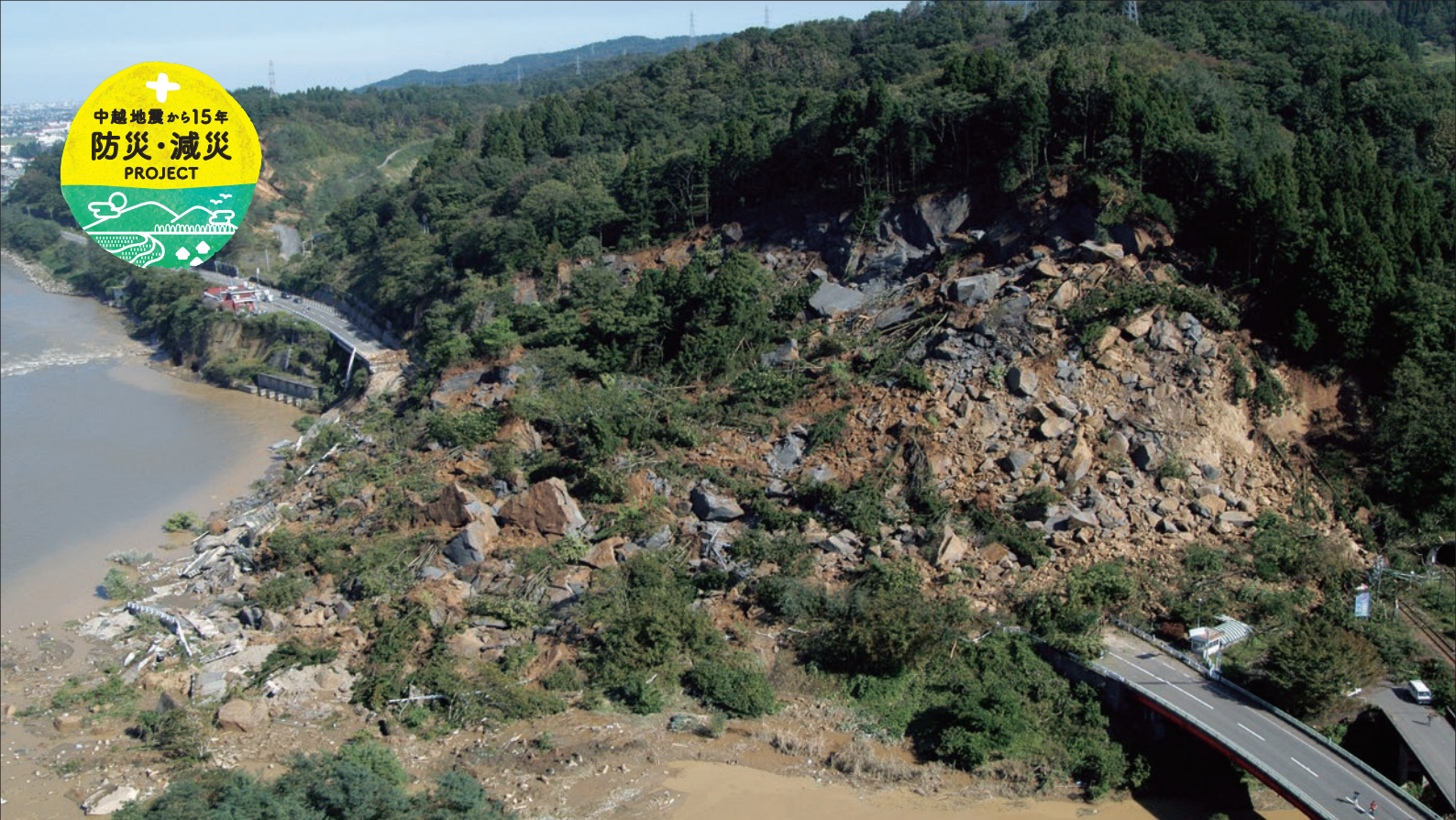
土砂崩れにより寸断された旧国道17号(長岡市妙見町)
