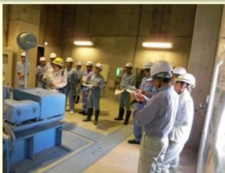
主放流設備の点検状況説明
