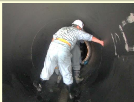
利水放流設備の点検状況説明
