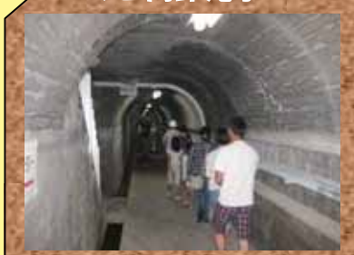
ダム内部見学
