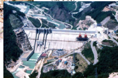
建設中 (S56) の大町ダム (左写真)
