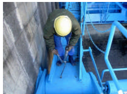
機械設備の点検
