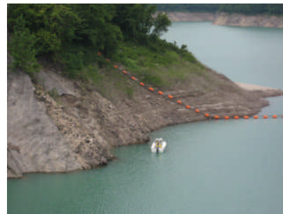
巡視船による 貯水池法面の 点検
