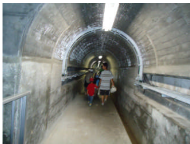
ダム内部見学
