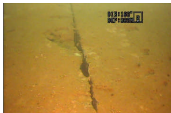
水中ロボットで見た減勢池底面の映像
