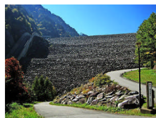
七倉ダム （東京電力㈱） 高瀬ダムよりは低いもののそれでも ロックフィルダム で日本 10 位の高さ 125m
