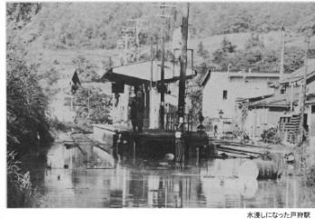
水浸しになった戸狩駅
