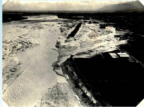
堤防決壊（松川村道の駅から約400m上流部）
