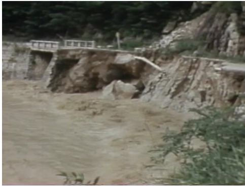
高瀬川左岸の道路が寸断した様子
