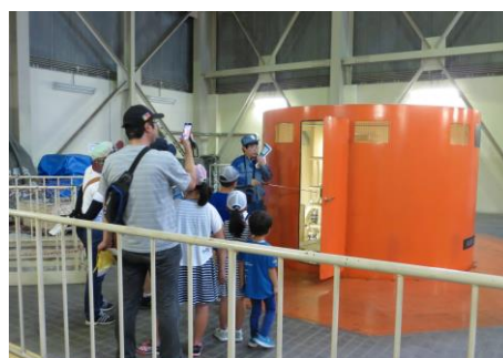
大町発電所内部見学
