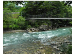
⑲笹平吊り橋と高瀬川
