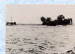
右岸堤防の決壊で桜川村から穂高町まで被害が及んだ。(桜川村郷野)
