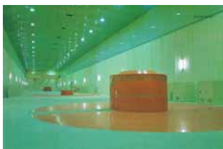
新高瀬川発電所
