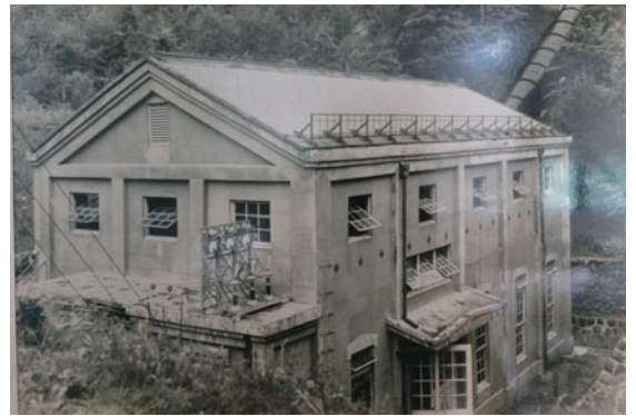
写真 5.6 旧高瀬川第一発電所(大正11年(1922)竣工) (出典:41)
