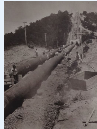
写真 5.7 高瀬川第三発電所工事中の写真 (出典:41)
