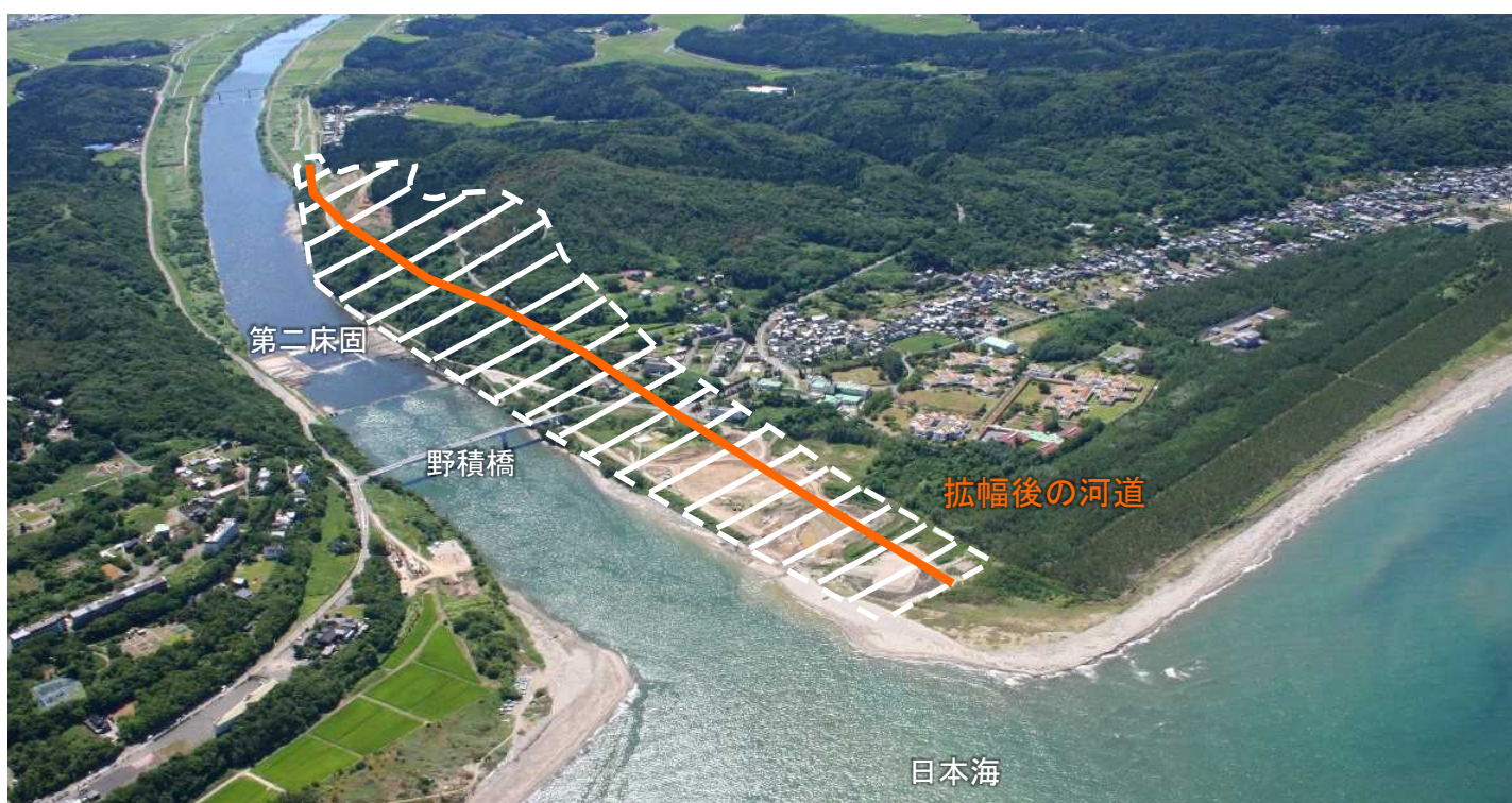
洪水処理能力向上のため改修が進む、信濃川の洪水から越後平野を守る大河津分水路（長岡市・燕市）
