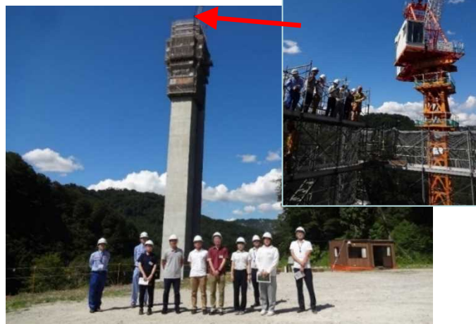
山間部で建設中の高さ約80mの橋脚
