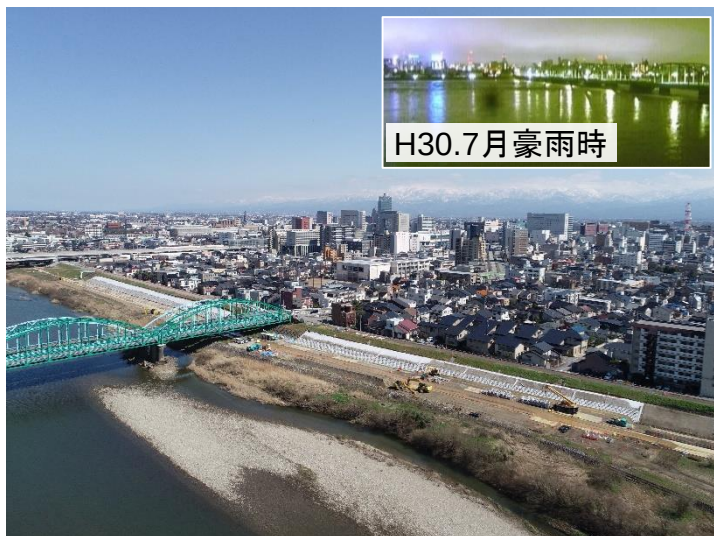
富山市街地を守る、河川堤防重点防御事業（富山市）
