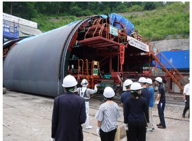
迫力あるトンネル掘削工事を目前で体感
