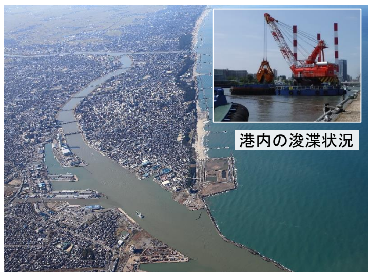
地域の経済・生活を支える新潟港の維持浚渫（新潟市）
