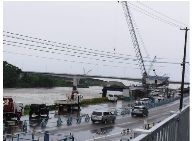
令和の大改修である大河津分水路の工事現場
