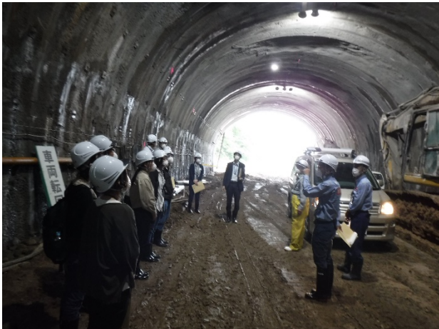
迫力あるトンネル掘削工事を間近で体感
