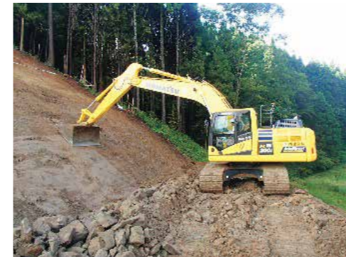
ICT建設機械による土工(法面整形)
