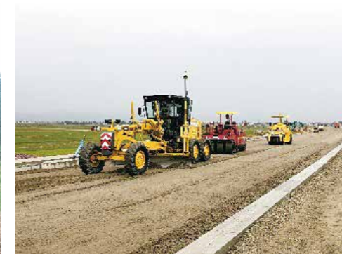
ICT建設機械による舗装(路盤)の敷均し
