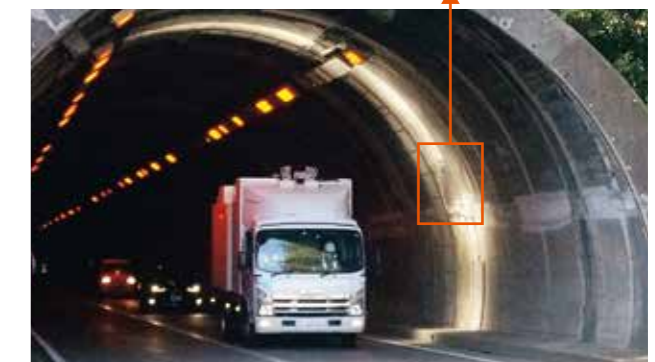
点検ロボットを利用したトンネル点検
