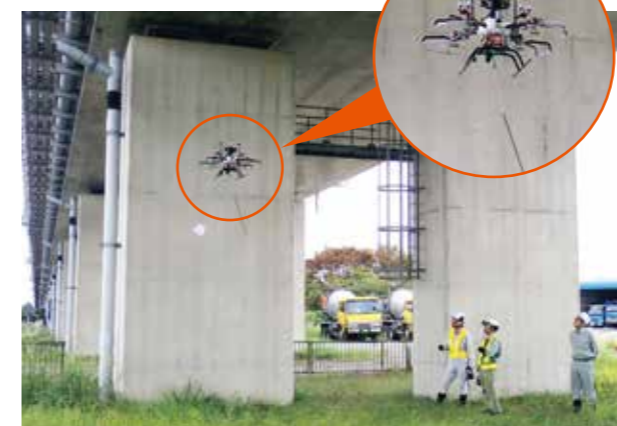
マルチコプタを利用した橋梁点検
