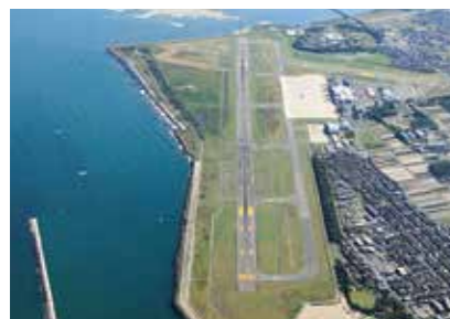
新潟空港 大規模地震から空港を守る滑走路の耐震化(新潟県新潟市)
