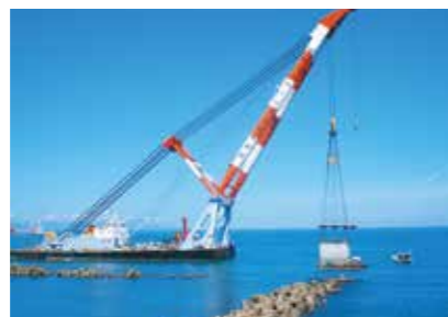
新潟港海岸 波浪による海岸侵食を防ぐ海岸(突堤)の整備(新潟県新潟市)
