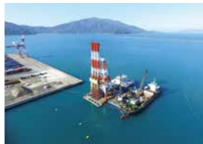
敦賀港 国際物流ターミナルの岸壁の整備(福井県敦賀市)
