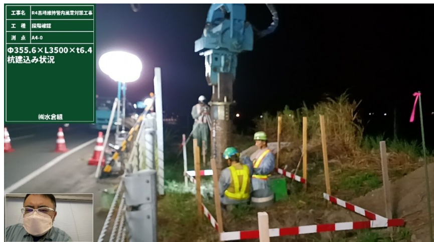
図-2 夜間における遠隔臨場の様子(打込時)
