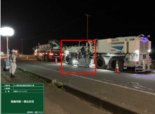
路面切削状況
