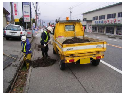
側溝清掃の状況
