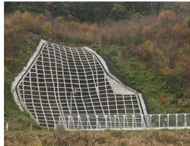
法枠による対策状況
