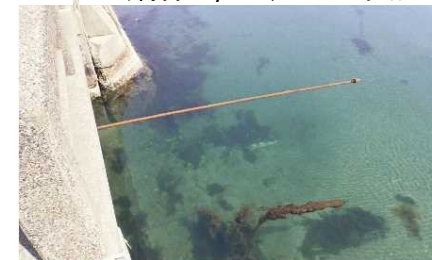
(海側) PC鋼棒 φ23, L=3m突出
