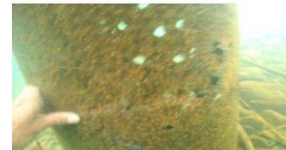
鋼管の腐食状況
