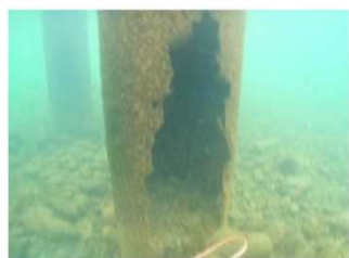
▲パイルベントの断面欠損
