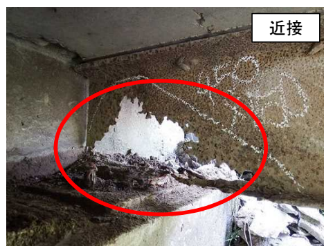
近接目視により断面欠損を確認
