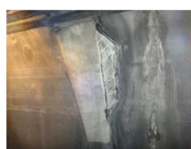
▲トンネル目地部
