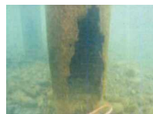
▲橋脚水中部の断面欠損
