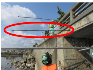
▲PC鋼材の突出事例
