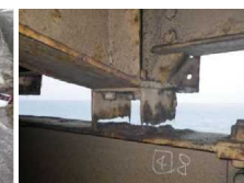
▲シェッド主梁端部破断
