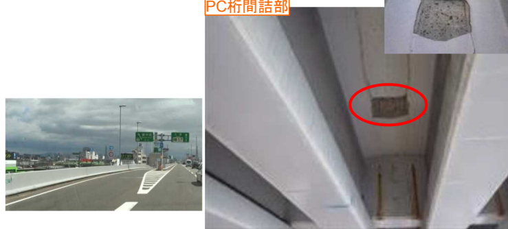
PC桁間詰部
