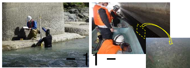
▲潜水士による洗掘調査
