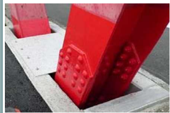
▲破断箇所の修復
