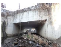
▲水路ボックス
