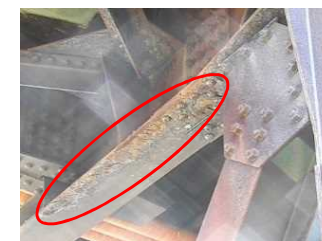
耐候性鋼材に層状の剥離
