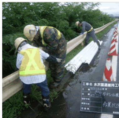
<防護柵の取替>
