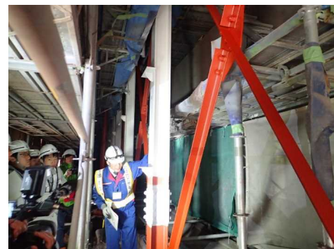
措置(補修)内容の現地確認
