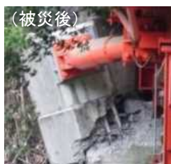
制震ダンパー取付部の損傷
