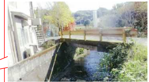
老朽橋の撤去
