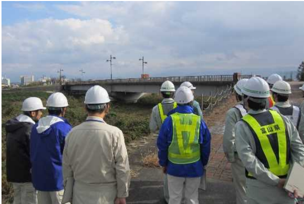
平成29年度土木技術職員研修(道路)
