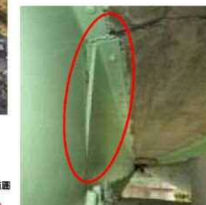
主桁の変形
