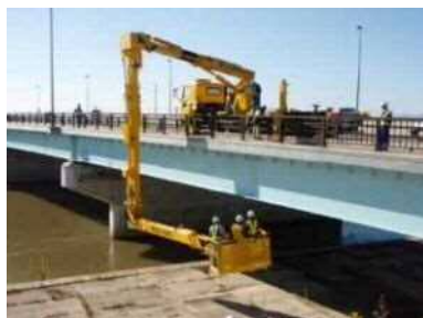
橋梁点検車による点検
