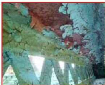
鋼材の腐食
