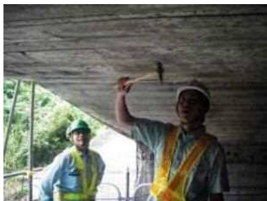
目視及びハンマーによる打音検査
