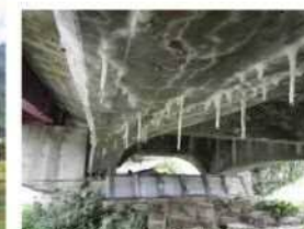
主桁のひびわれ
