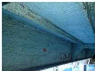
桁の塗装劣化やさびの発生
