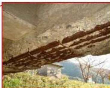
主桁の剥離、鉄筋露出
