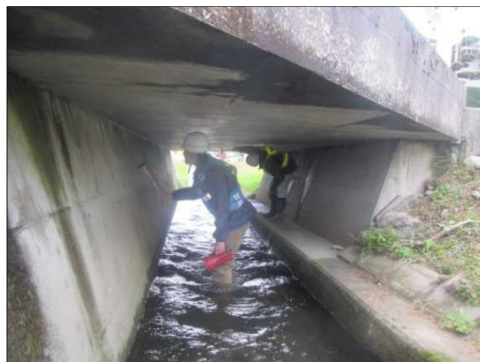
入善町(直営点検橋梁:77橋)
