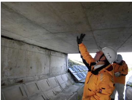
立山町(直営点検橋梁:55橋)
