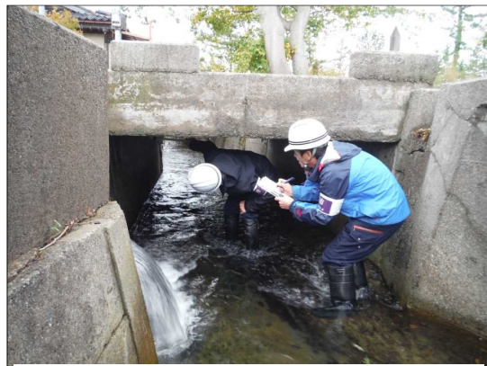
滑川市(直営点検橋梁:80橋)
