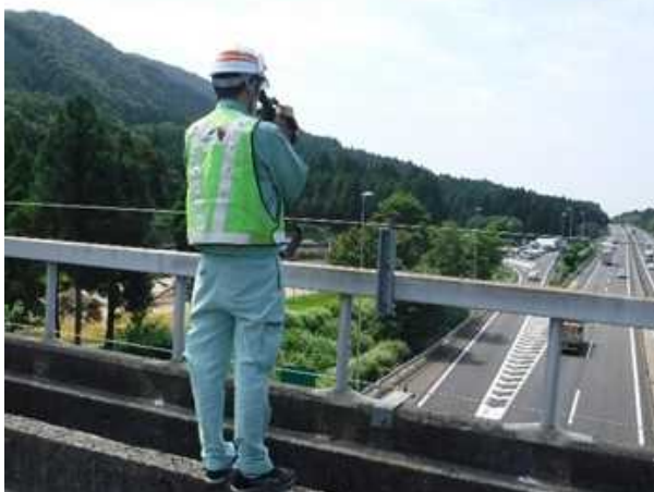
赤外線カメラによる撮影状況
