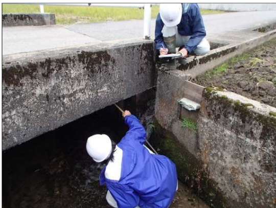
魚津市(直営点検橋梁:27橋)
