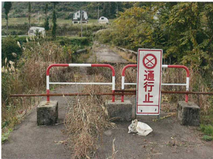
通行止め状況
