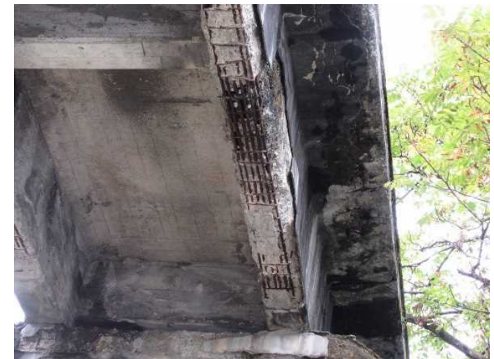
主桁の鉄筋露出
