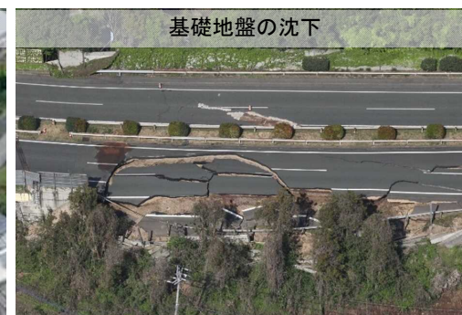
写真-10 九州自動車道 (益城町)
