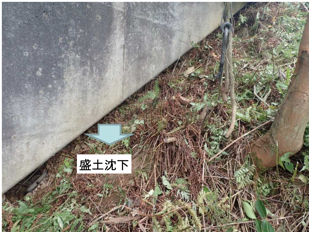
【ウイング下面の盛土沈下】
