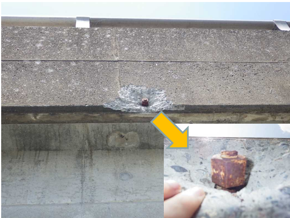
【PC床版横締め鋼棒の破断】
