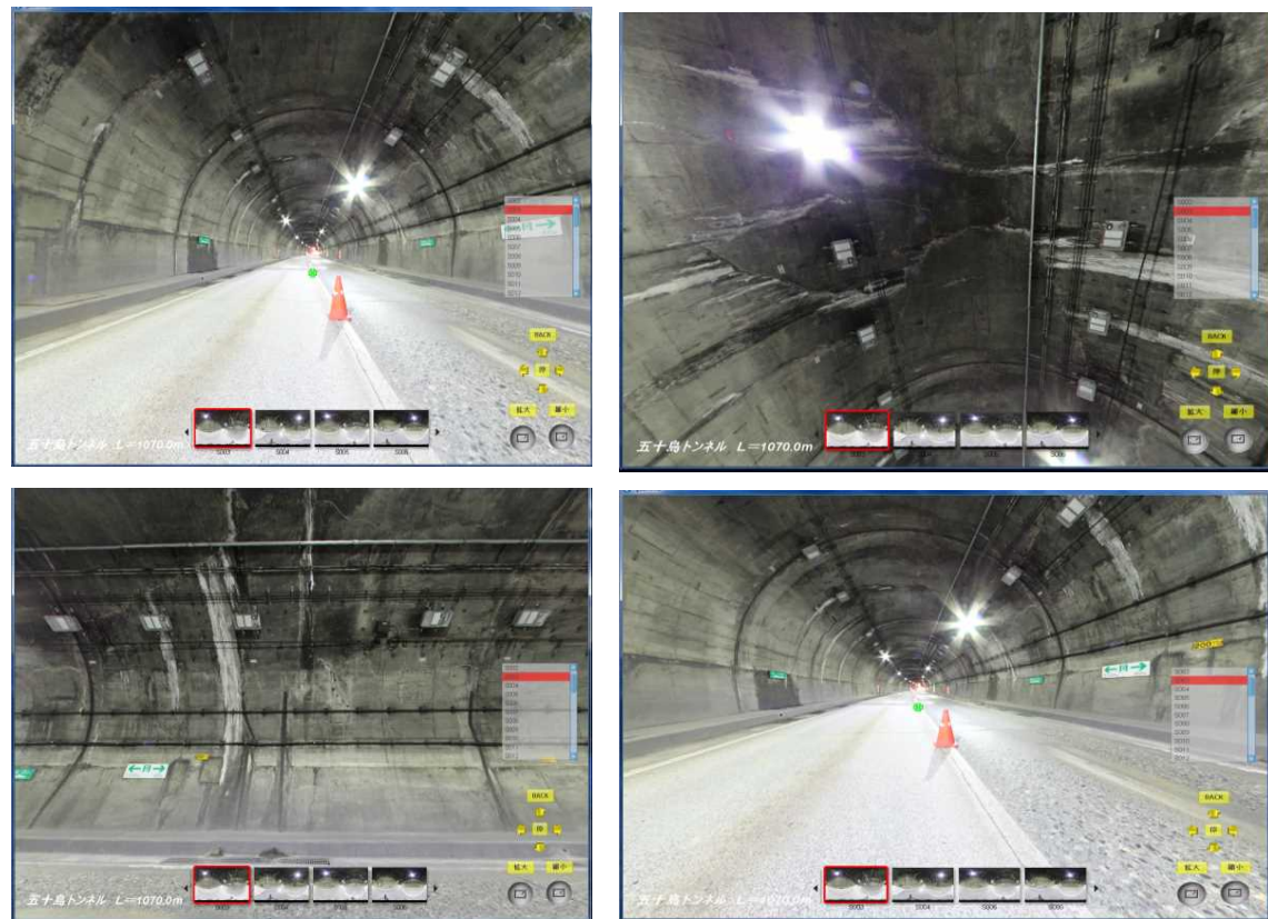
覆工壁面・路面連続画像
