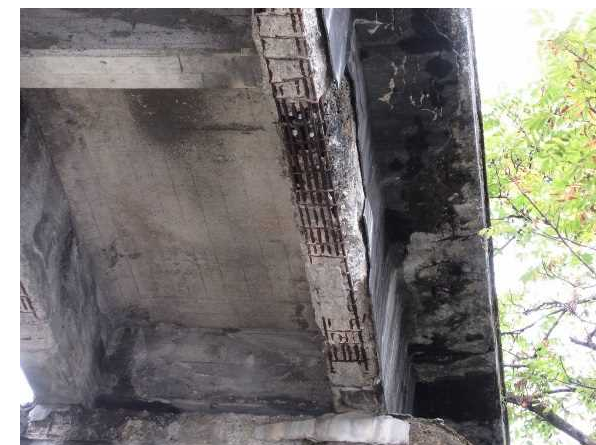
主桁の鉄筋露出
