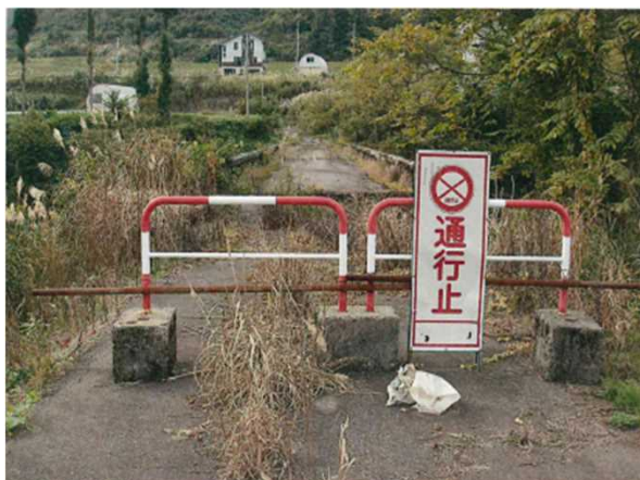
通行止め状況
