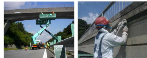
点検実施状況
