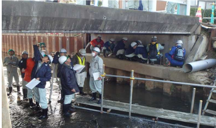
市町村が管理する橋梁で職員自ら点検(11月4日 新潟県三条市)
