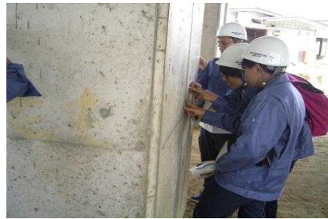
ひび割れ幅を測定している状況
