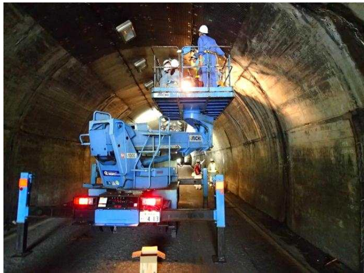
9/3 トンネル点検研修(近接目視点検と打音調査)
