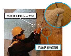
図-5 設置時確認
