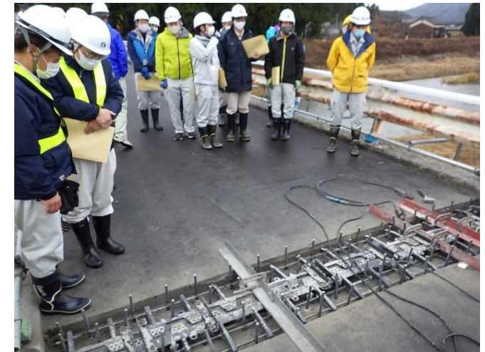
補修工事現場研修会
