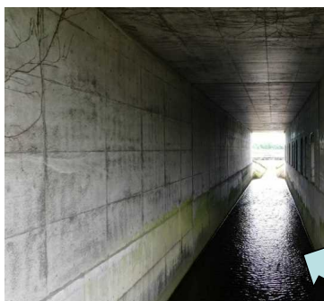
点検困難な水路BOX
