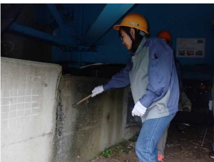
点検ハンマーによる橋梁点検実施状況
