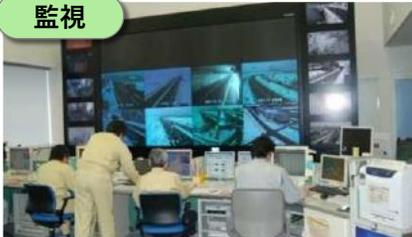
道路上に設置されている情報収集機器（CCTVカメラ、気象観測装置等）を用いて道路情報を把握し、道路利用者に情報提供を行います。
