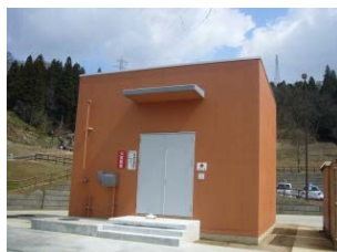
非常用電源装置
