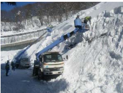
雪庇処理の状況
